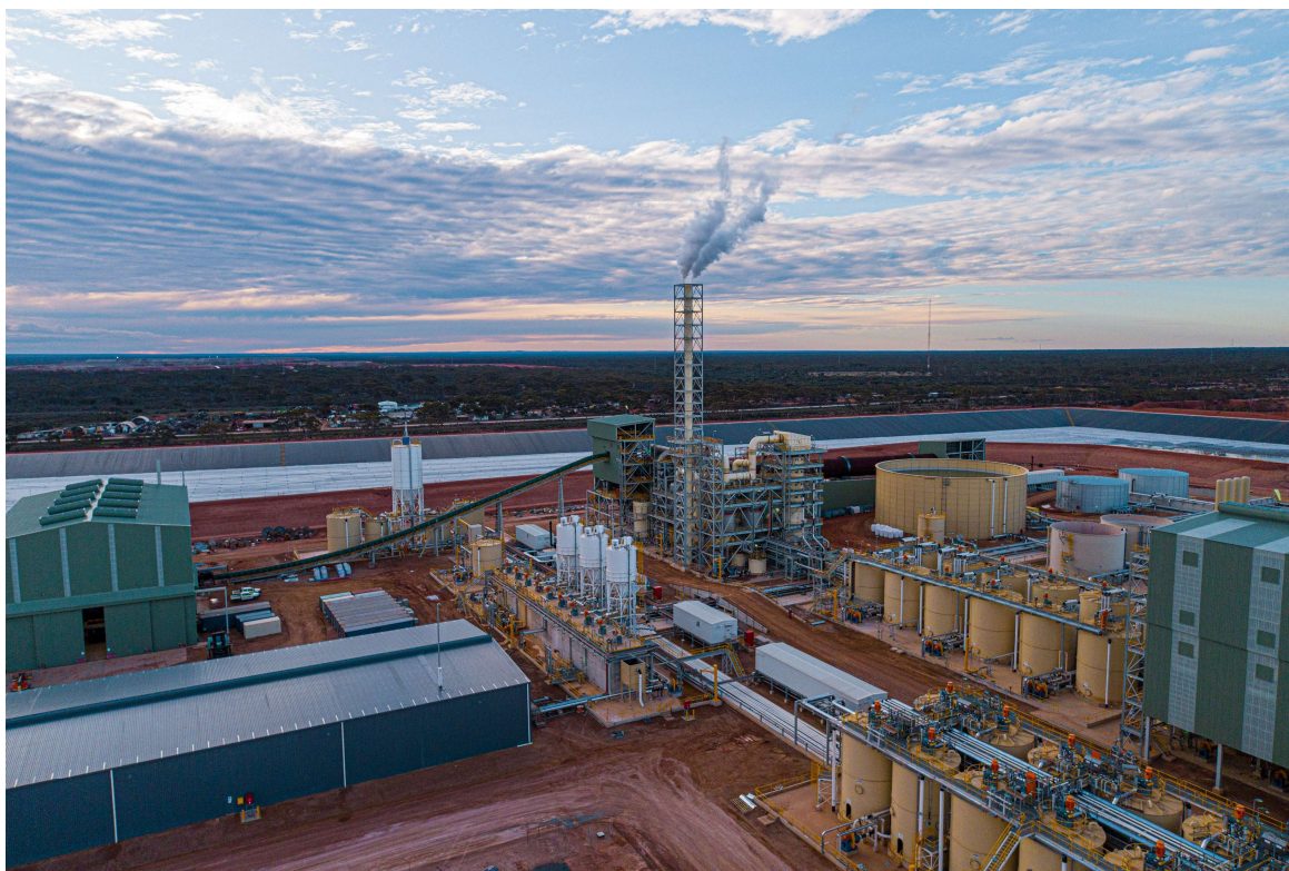
废气处理装置去除回转窑中气体中的杂质，然后将其作为蒸汽释放
